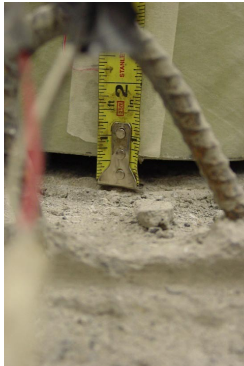
(d) Column-base interface of southern column
